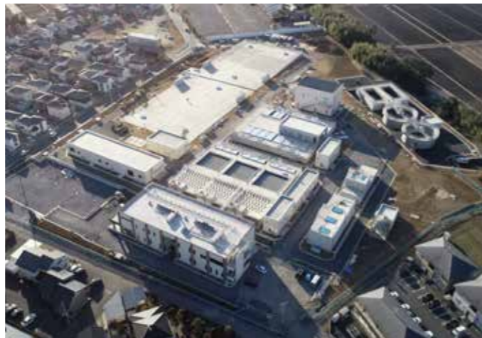
▲新上坪浄水場
