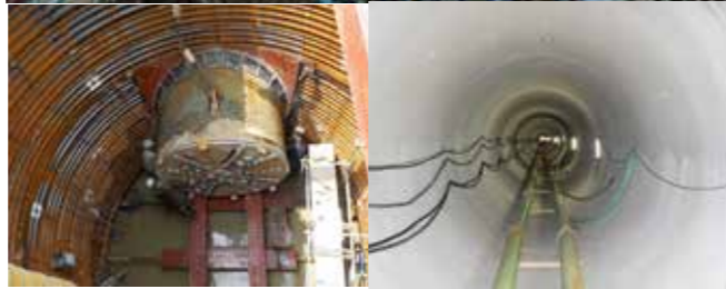
▲雨水の通り道となる雨水幹線整備
